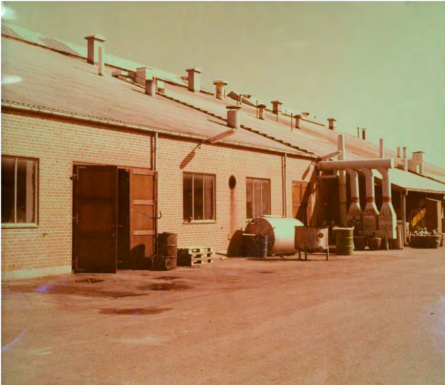
Billedet på forsiden viser afdeling B2 på et tidspunkt i 70'erne. "Ribosen" ligger inde bag muren og anlægget uden for bygningen er filteranlægget på udsugningen.
